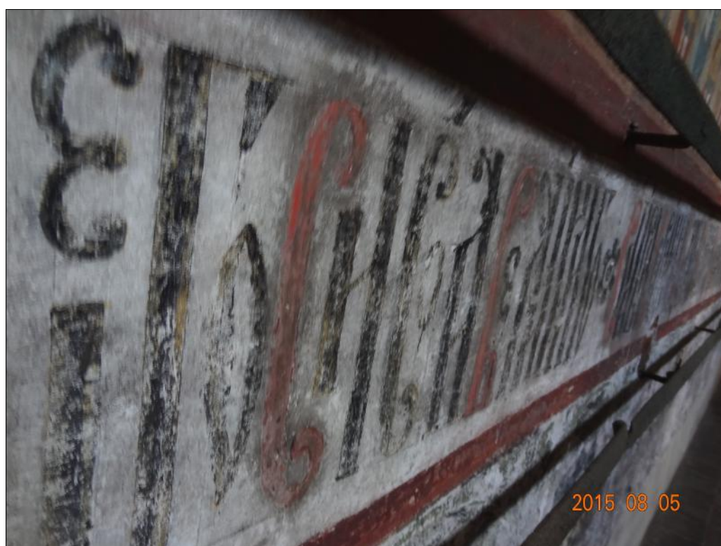
Фото 42. Ярославль. Церковь Иоанна Предтечи. Общий вид (а), фрагмент надписи крупным планом (б). Состояние росписей до реставрации: развитие плесени, мелкая деструкция красочного слоя.
