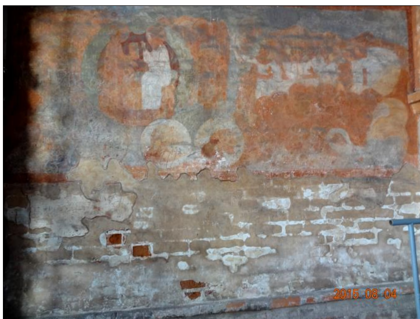
Фото 65. Ярославль. Спасо-Преображенский монастырь. Святые ворота Состояние красочного слоя в нижней части стен (а,б). Церковь Богоявления
