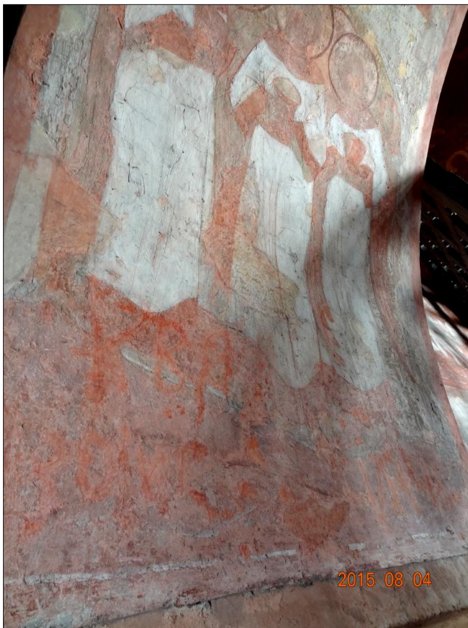
Фото 62. Ярославль. Спасо-Преображенский монастырь. Святые ворота. Фрагмент живописи на склоне арки. Утрата, отслоение живописного слоя.
