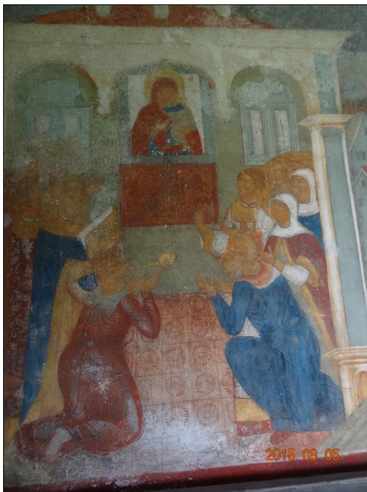
Фото 40. Ярославль. Церковь Иоанна Предтечи. Галерея. Сюжет с Богородицею. Деструкция красочного слоя, высолы.
