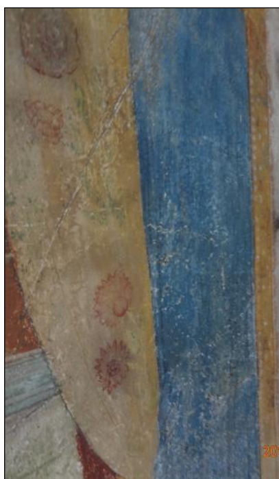
Фото 33. Ярославль. Церковь Иоанна Предтечи. Галерея. Сюжет с образом Николы Чудотворца (а); фрагмент одежд Святого крупным планом (б). В отдельных участках налет плесени, высолы на одеждах святого.
