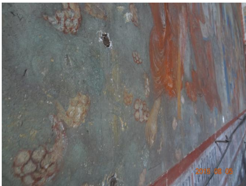
Фото 43. Ярославль. Церковь Иоанна Предтечи. Общий вид стенописи северной стороны западной стены (а), фрагмент надписи крупным планом (б, в, д). Состояние росписей до реставрации: развитие плесени, мелкая деструкция, утрата штукатурки с красочным слоем.
