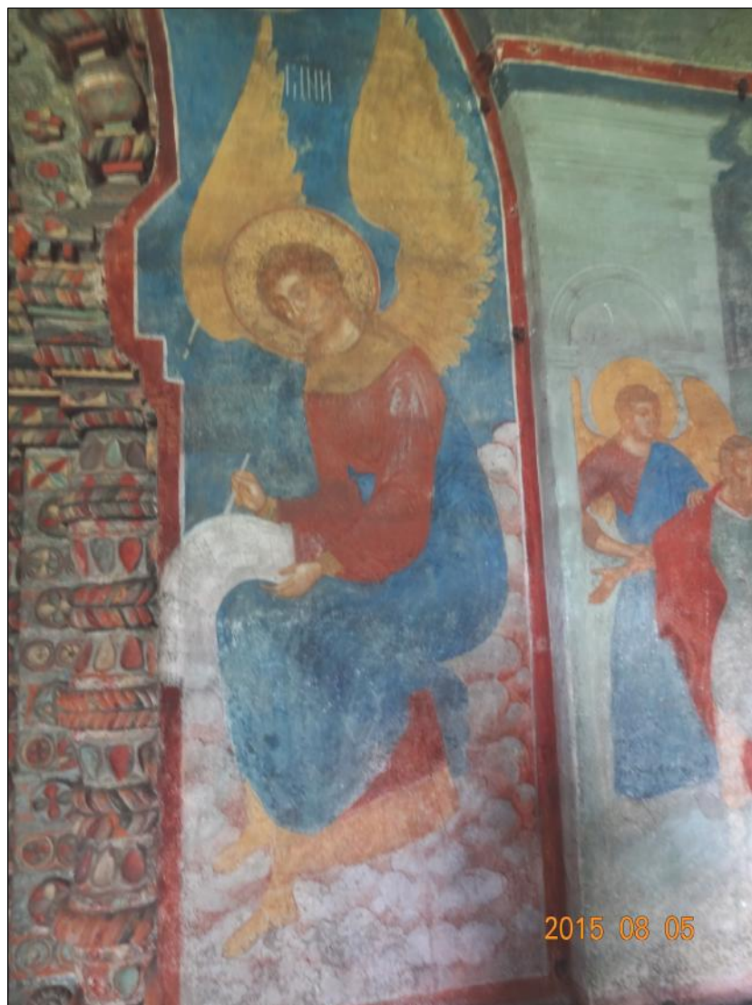
Фото 41. Ярославль. Церковь Иоанна Предтечи. Фрагмент Сюжета справ от входа в четверик. Развитие плесени на поверхности живописного слоя.
