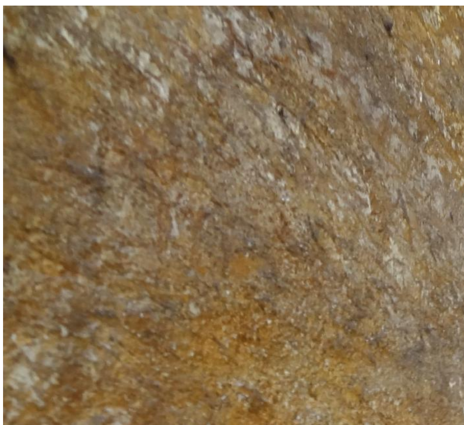
Фото 68. Ярославль. Церковь Богоявления. Северная стена, нижняя часть. Состояние живописи во втором регистре в нижней части крупным планом: Осыпание и утрата живописного слоя до грунта.
