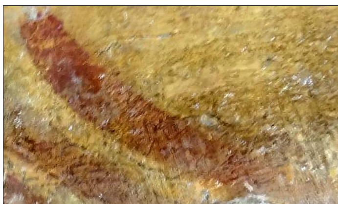
Фото 69. Ярославль. Церковь Богоявления. Южная стена, нижняя часть (участок взятия пробы №Я/6) (а). Состояние живописи крупным планом: отслоение и осыпание до грунта, присутствие копоти и загрязнений на поверхности красочного слоя (б).
