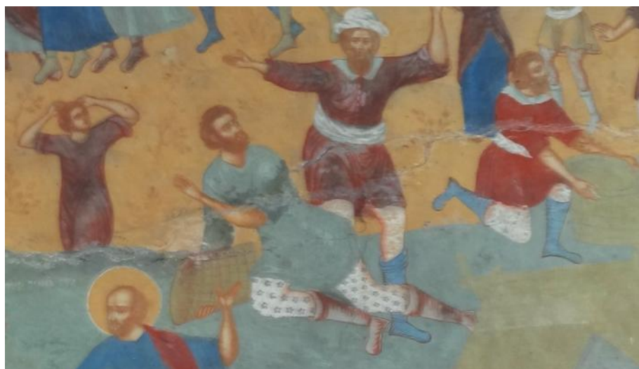
Фото 36. Ярославль. Церковь Иоанна Предтечи. Галерея. Фрагмент сюжета на склоне свода (а). Состояние живописного слоя (трещина по штукатурке, высолы, развитие плесени на поверхности красочного слоя..
